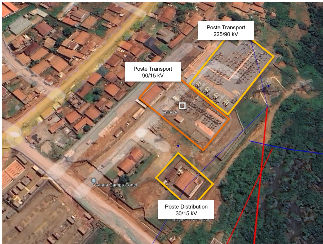
Figure 1 : Image du poste de Ahala
